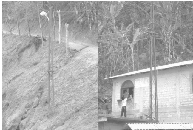
Figura 26. Infraestructura de electrificación en Orilla del Llano con postes metálicos.
