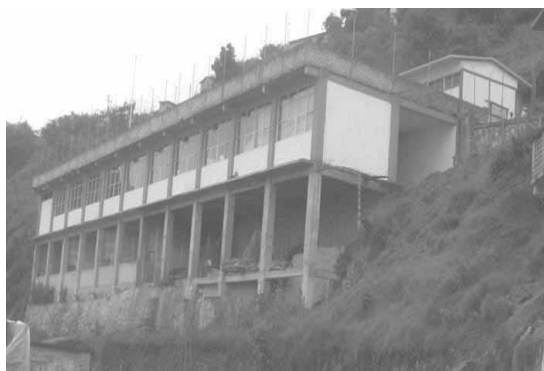
Figura 19. Infraestructura de la Escuela Primaria en la Cabecera Municipal
