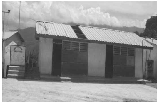
Figura 21. Infraestructura de la Escuela Primaria de la Agencia de policía de Cerro Moneda.
