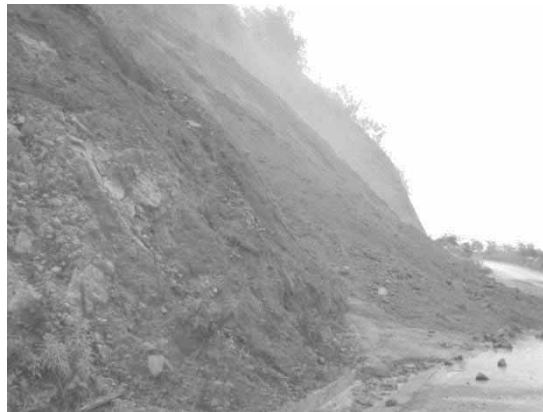
Figura 38. Derrumbe en la carretera debido a excesos de lluvia.
