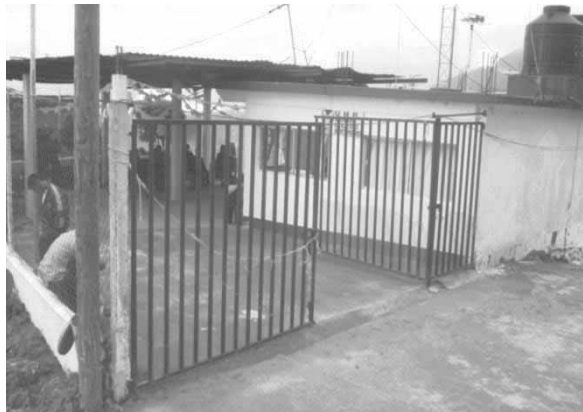
Figura 23. Infraestructura de la Clínica en la Cabecera Municipal.
