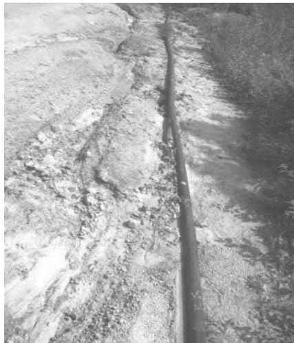
Figura 12. Suministro de agua a través de mangueras, Asunción Cacalotepec.
