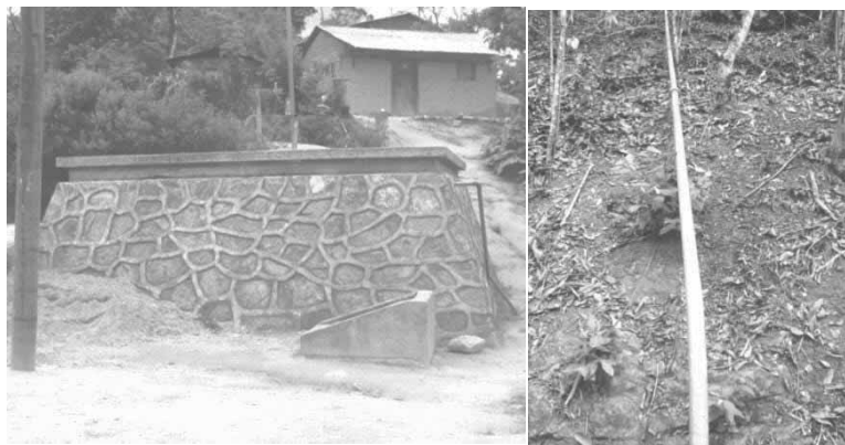
Figura 28. Tanque de almacenamiento de agua en la parte alta de la población de Cerro Moneda y distribución en tubo galvanizado.
