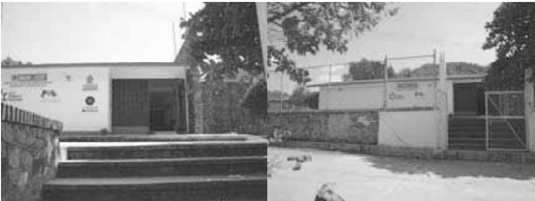
Foto 3. Instalaciones del Centro de Salud del municipio de Asunción Tlacolulita.
