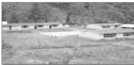
Figura C1.9 Bachillerato Integral Comunitario No. 3 (Morales, J., 2008)
