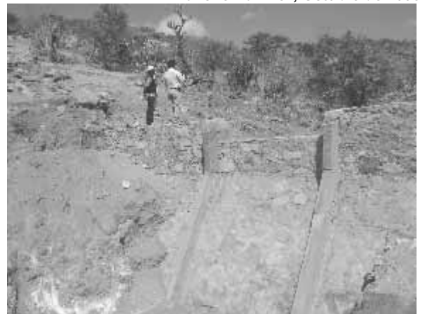
Recorrido a obras de conservación de suelo y agua II. Magdalena Tetaltepec, Octubre de 2008.
