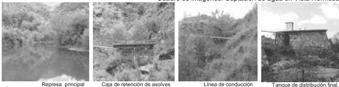
Cuadro de imágenes. Captación de agua en Vista Hermosa
