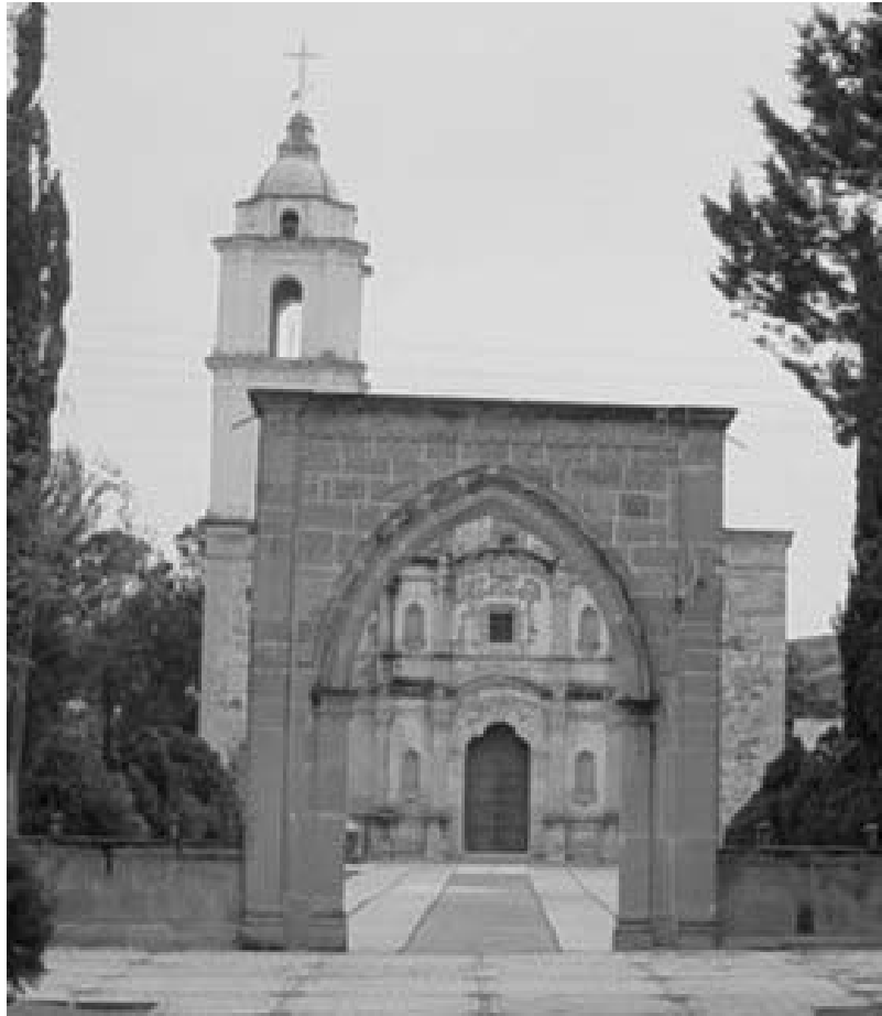
Pórtico principal del templo católico
