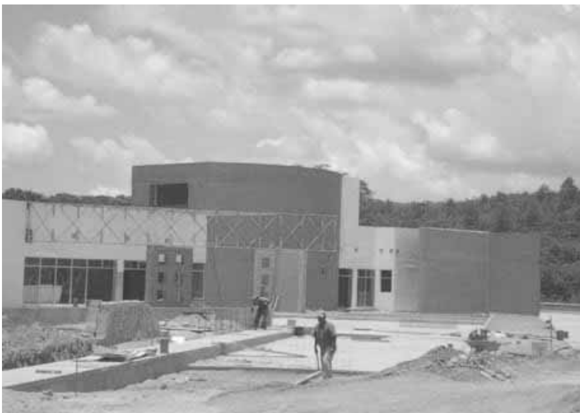
Construcción del Hospital de 2° Nivel
