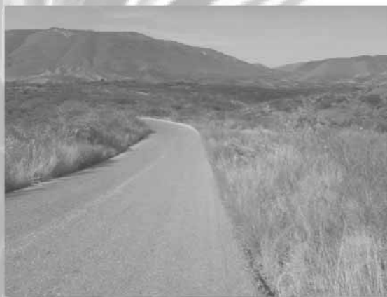
Fotografía 16. Tramo con recubrimiento asfáltico, de acceso al municipio
