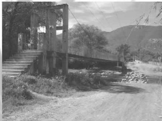
Fotografía 9. Acceso norte al Barrio de la Soledad, puente peatonal.
