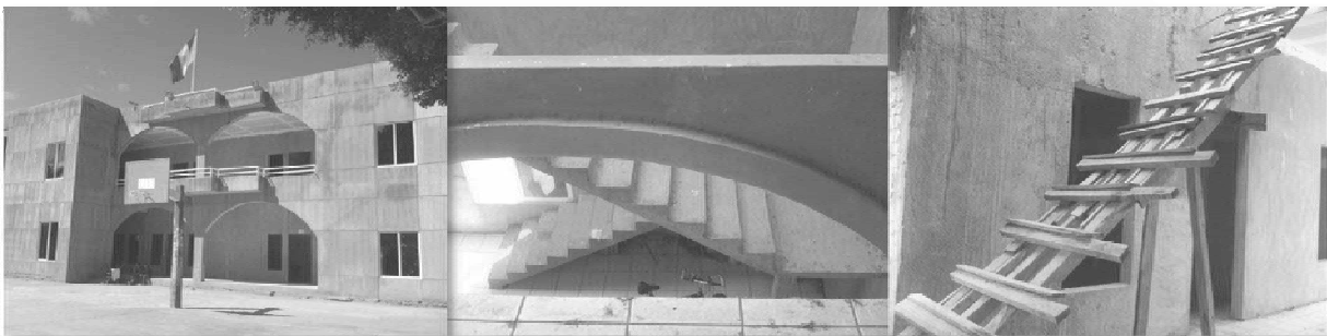
Fotografía 33, 34 y 35. Condiciones actuales del palacio municipal
