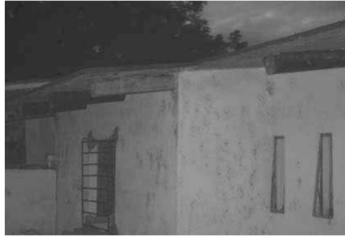
Fot. 2 Casa de salud en rehabilitación
