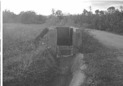
fot. 4 canal de riego
