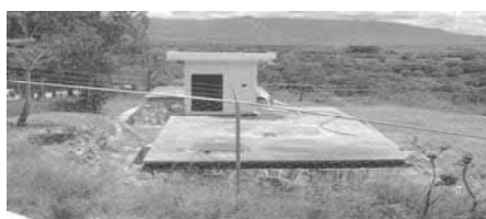
tanque de almacenamiento
