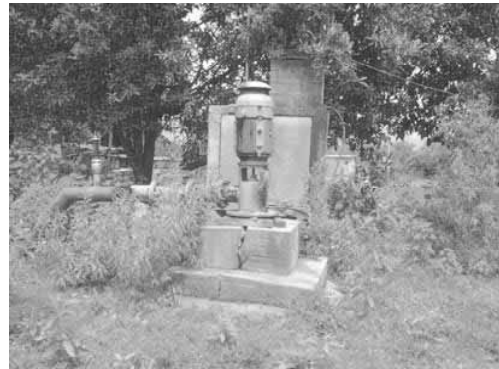
fot. 6 pozo no.2 para riego
