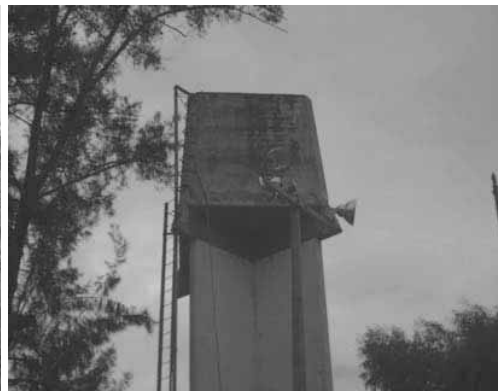
fot. 6 tanque de almacén de agua pot.
