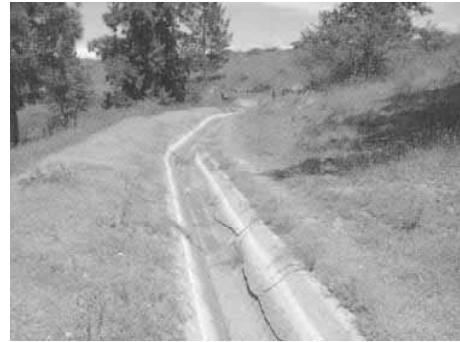
Fot. 2 Canal para riego en mal estado
