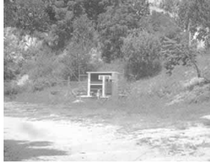
fot. 13 bomba para el tanque de agua
