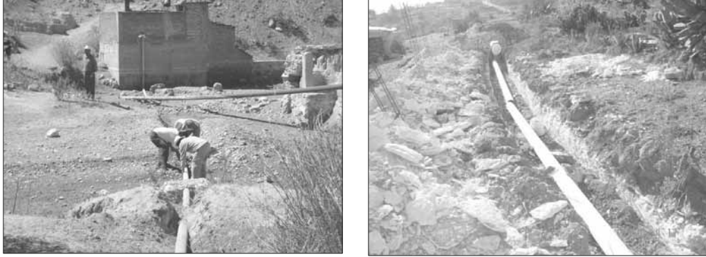
Figura. Modernización y ampliación de la red de distribución de agua “río la cruz”
