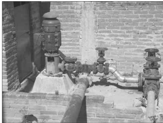
Figura. Equipamiento del pozo noria
