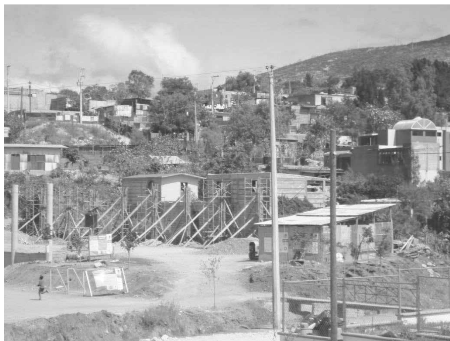
Fotografía 3: Construcción de la unidad deportiva, octubre 2008.
