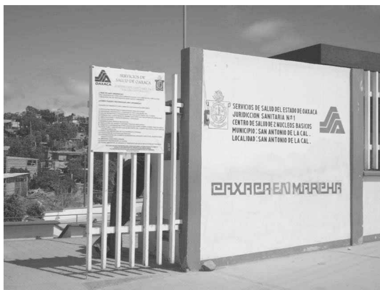
Fotografía 2: Centro de Salud San Antonio de la Cal.
