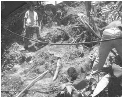
Foto N° 17: Manguera por la cual se conduce el agua a las viviendas.
