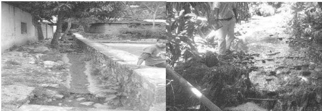
Foto N° 20: Contaminación de los arroyos.
