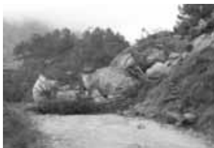
Figura 8. Erosión del suelo
