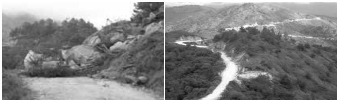
Figura 15 caminos y carreteras
