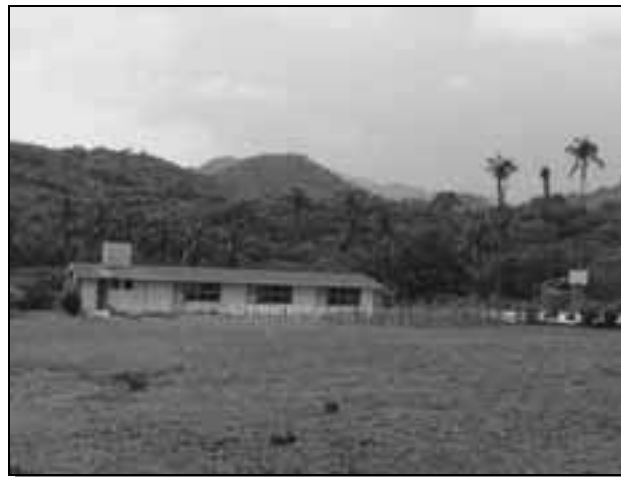
Fig. No. 10 Instalaciones del IEBO de San Bartolo Yautepec.
