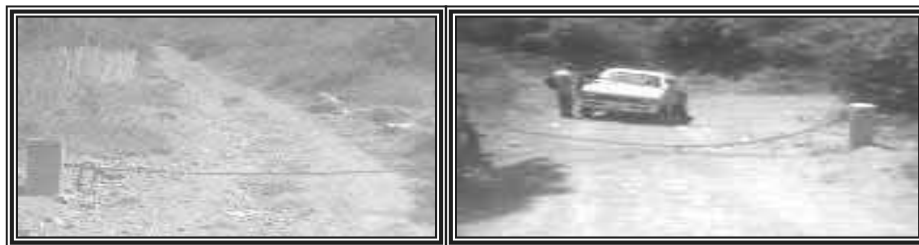
Foto. No. 4 Aspecto de la carretera Santa Ana Tavela – Santa María Nizaviguiti
