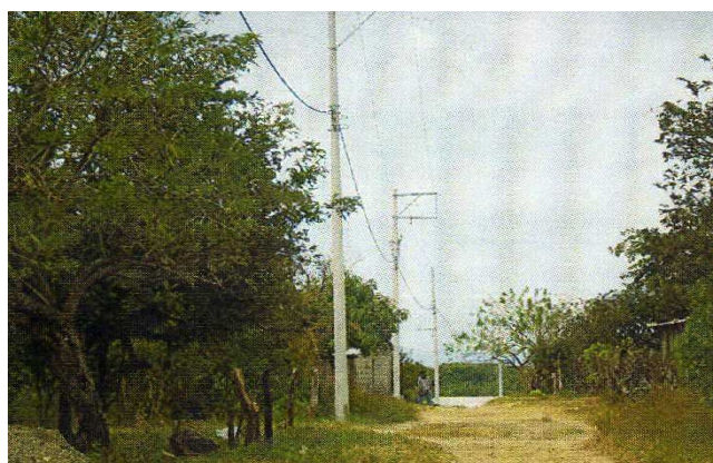
Figura 7. Servicio de energía eléctrica monofásico
