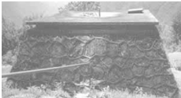
Figura 33. Infraestructura de red de agua potable del municipio de San Francisco Ozolotepec.
