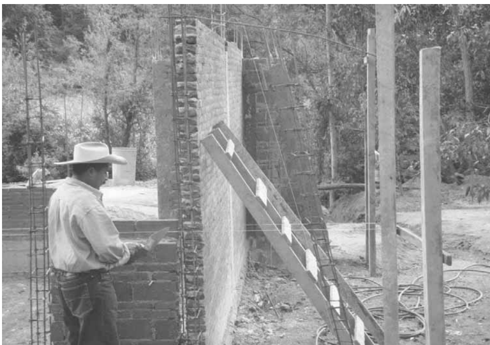
Construcción de aulas en Yojuela
