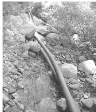
Entubado de agua
