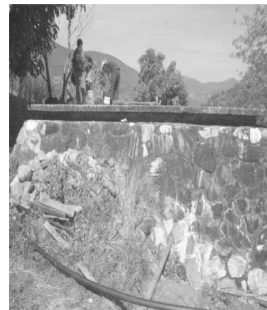
Rehabilitación de tanque
