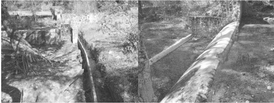
Tanque de Agua para Riego
