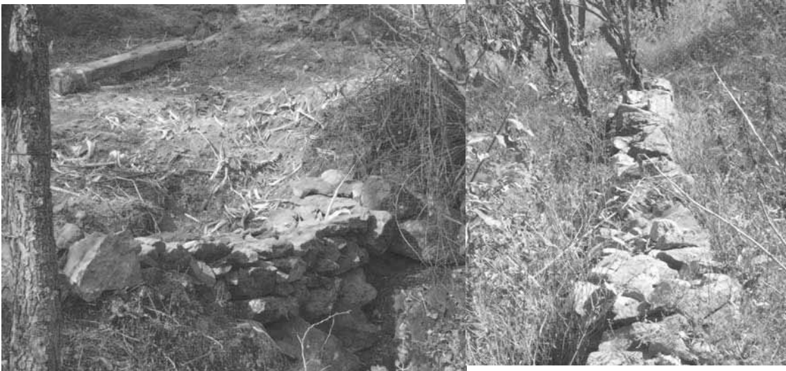
Estado Actual del Canal de Riego
