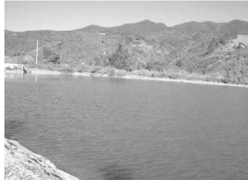
2.- Tanque de agua para riego.
