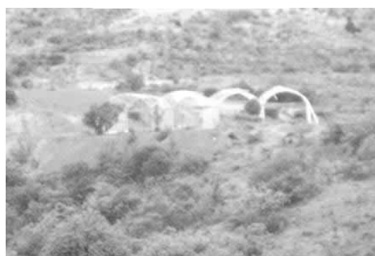
4.- Invernadero sin cubierta
