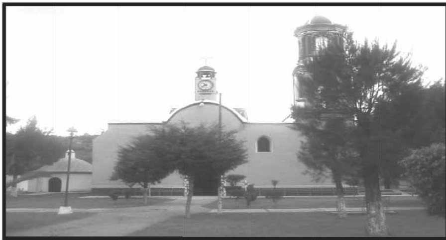
Fig.6 Iglesias de la Cabecera Municipal de San Juan Mixtepec.
