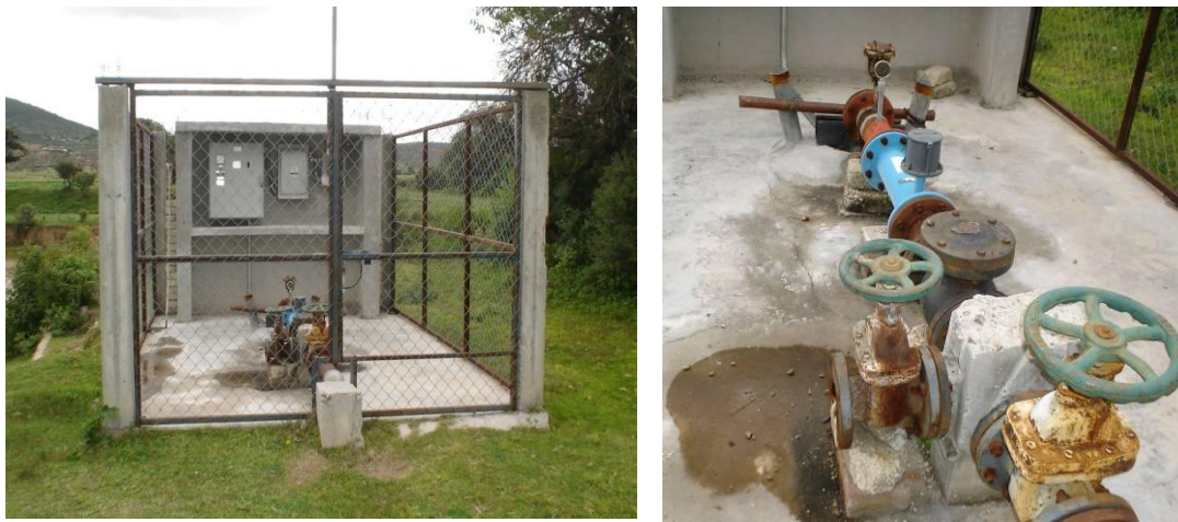
Pozo de mayor abastecimiento de agua potable "Río Verde", Yucuita.
