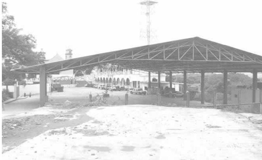
FOTOGRAFIA NO. 19 : INFRAESTRUCTURA DEPORTIVA MUNICIPAL
