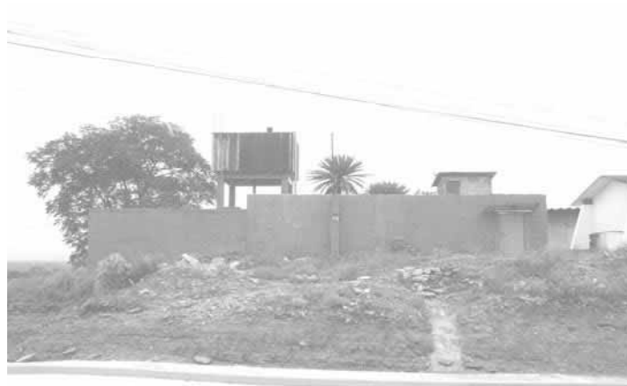
FOTOGRAFIA NO. 18 : TANQUE ELEVADO DEL SISTEMA DE AGUA POTABLE DE LA CABECERA MUNICIPAL
