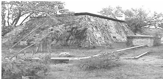
Foto 6: Depósito de agua ubicado en la Segunda Sección
