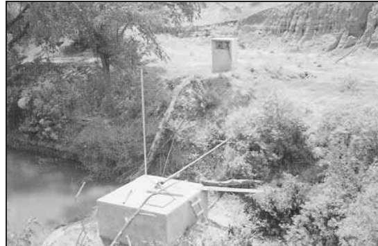
Figura 14-B. Depósito de agua FUENTE: ARCHIVO MUNICIPAL 2008
