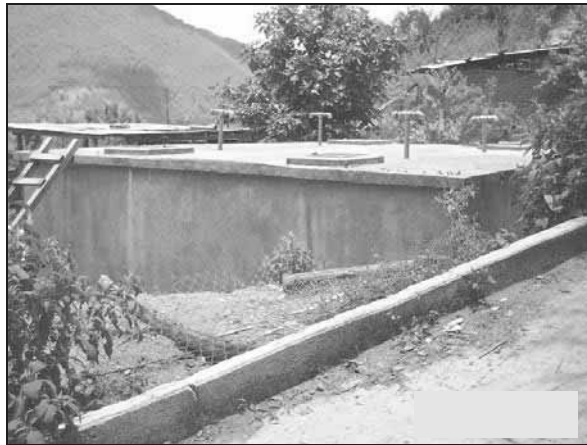
Foto 22. Tanque de almacén de agua potable.
