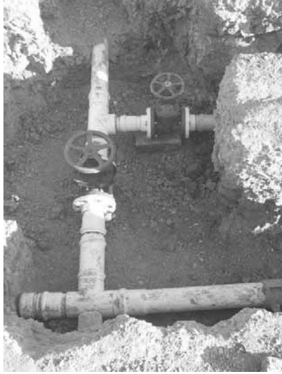
Rehabilitación de la red de agua potable
