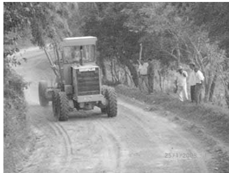
Fig. 17 Apertura de caminos de terracería
