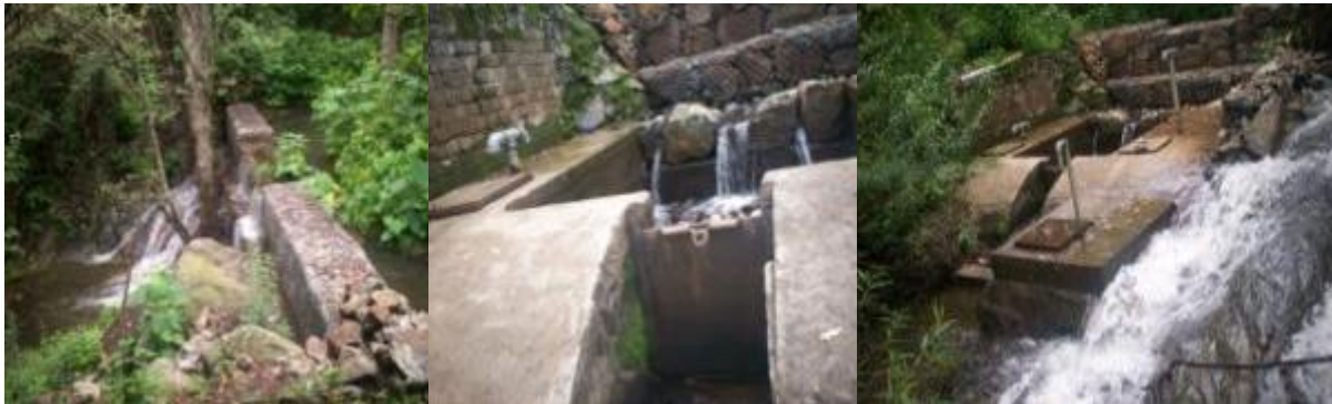
Imagen 4.7 Galería filtrante y cajas colectoras rompedoras de presión del sistema de agua potable
