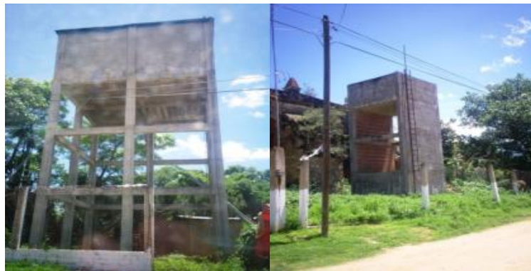
Imagen 4.10 Tanques de almacenamiento en hacienda blanca, el primero nunca pudo ser utilizado su calidad constructiva fue pésima y las filtraciones al momento de llenarlo fueron evidentes.
