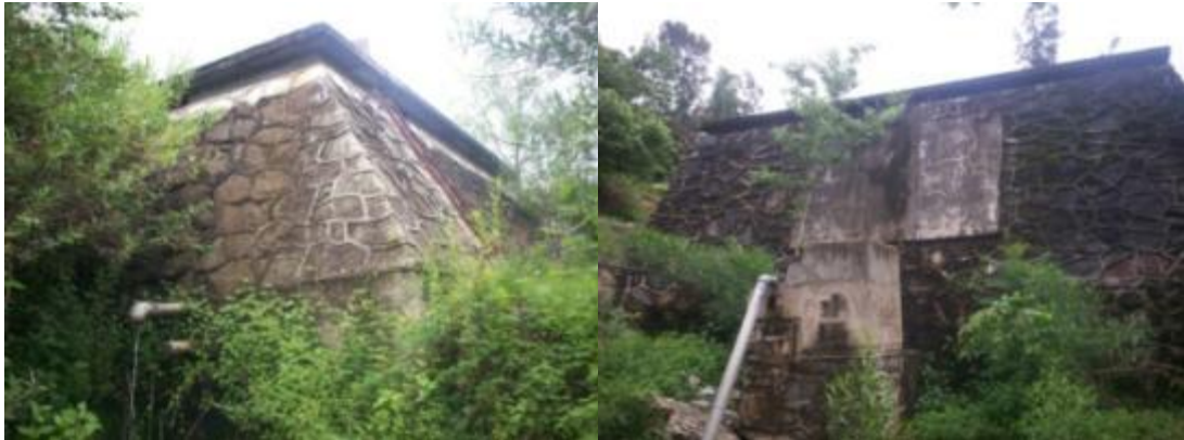
Imagen 4.8 Imágenes de tanques de almacenamiento actual y antiguo.
