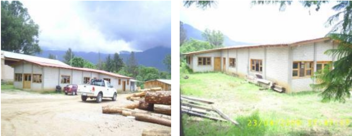
Imagen 5.8 Oficinas del aserradero que se encuentran a cargo del comisariado.
