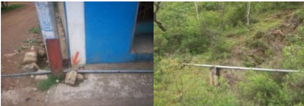
Imagen 4.5 Anexo Tuberías de agua potable en la población (línea de conducción).
