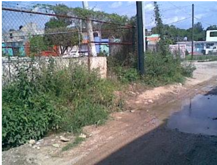
Imagen 2.5 Planta de tratamiento de aguas residuales del fraccionamiento “Barrio Morelos”
