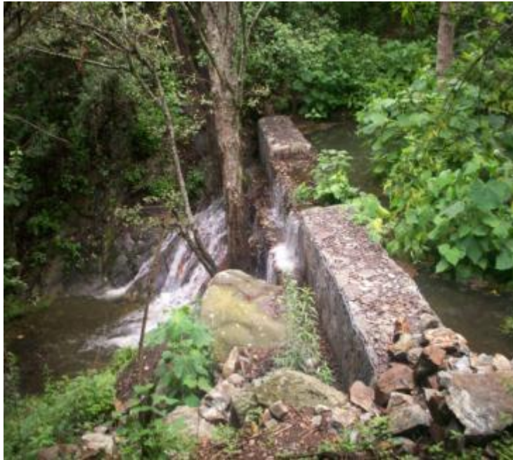
Imagen 2.7 Reten aguas arriba de la caja colectora
