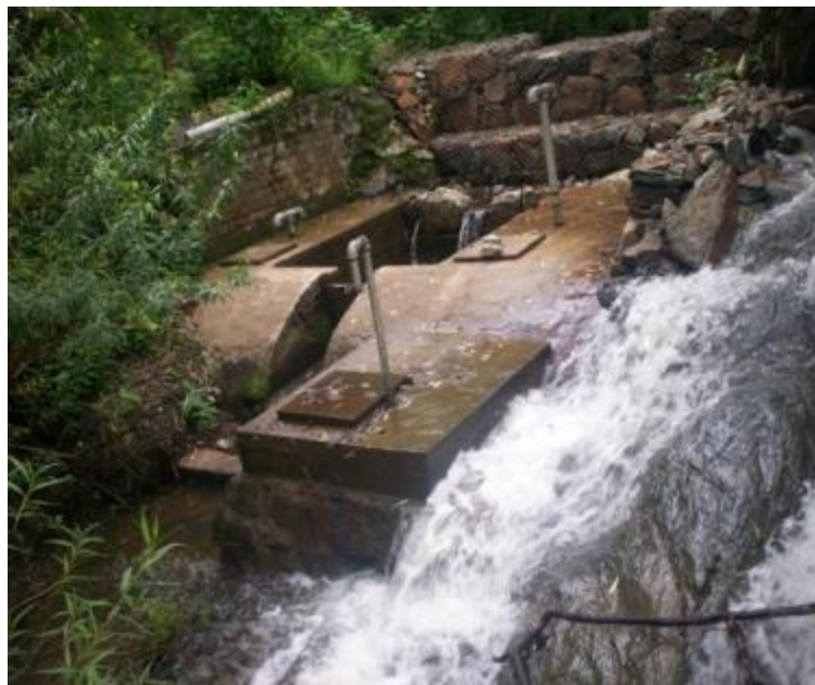
Imagen 2.8 Caja colectora para el sistema de Agua Potable
