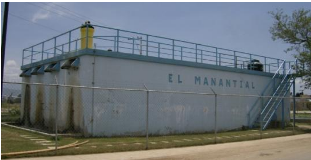
Imagen 3.3 Planta de Tratamiento de Aguas Residuales en el Fraccionamiento "El Manantial"
