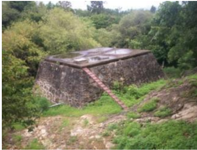
Ilustración 2.9: Tanque regulador del sistema de Agua Potable
