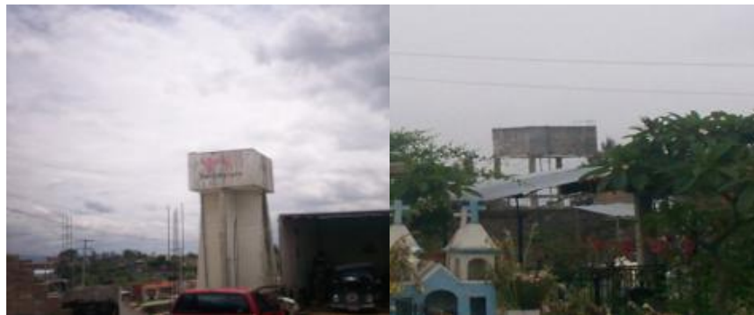
Imagen 4.9 Tanques de almacenamiento elevados.
