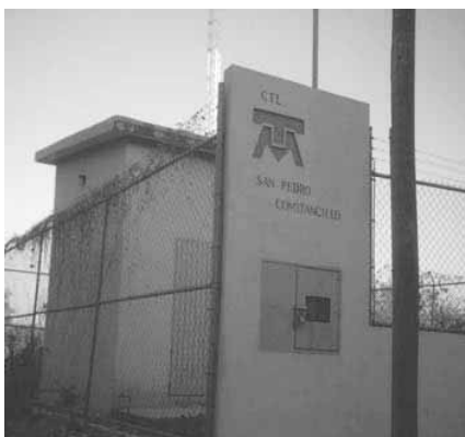
Instalaciones de Teléfonos de México.
