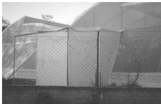
Infraestructura de invernadero
