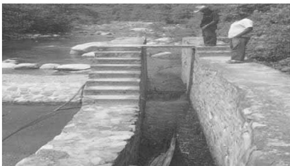
PRESA (DESVIACION DE LA REPRESA AL CANAL DEL RIO)
