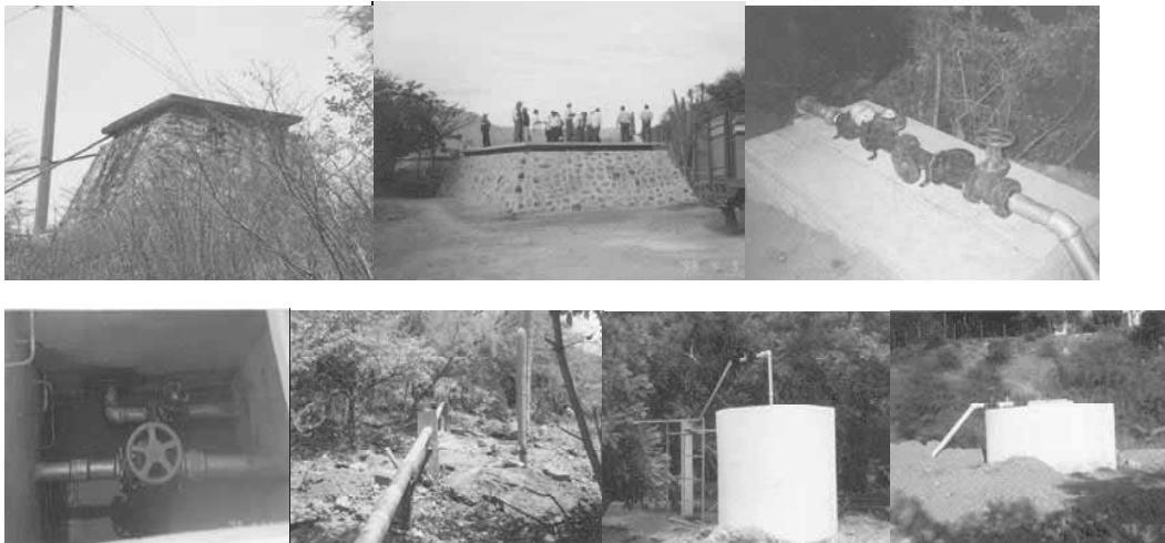
Fig. 12 Servicios de agua potable en las agencias y municipio.
