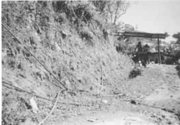
Foto 7.- Conductos para toma de agua.
