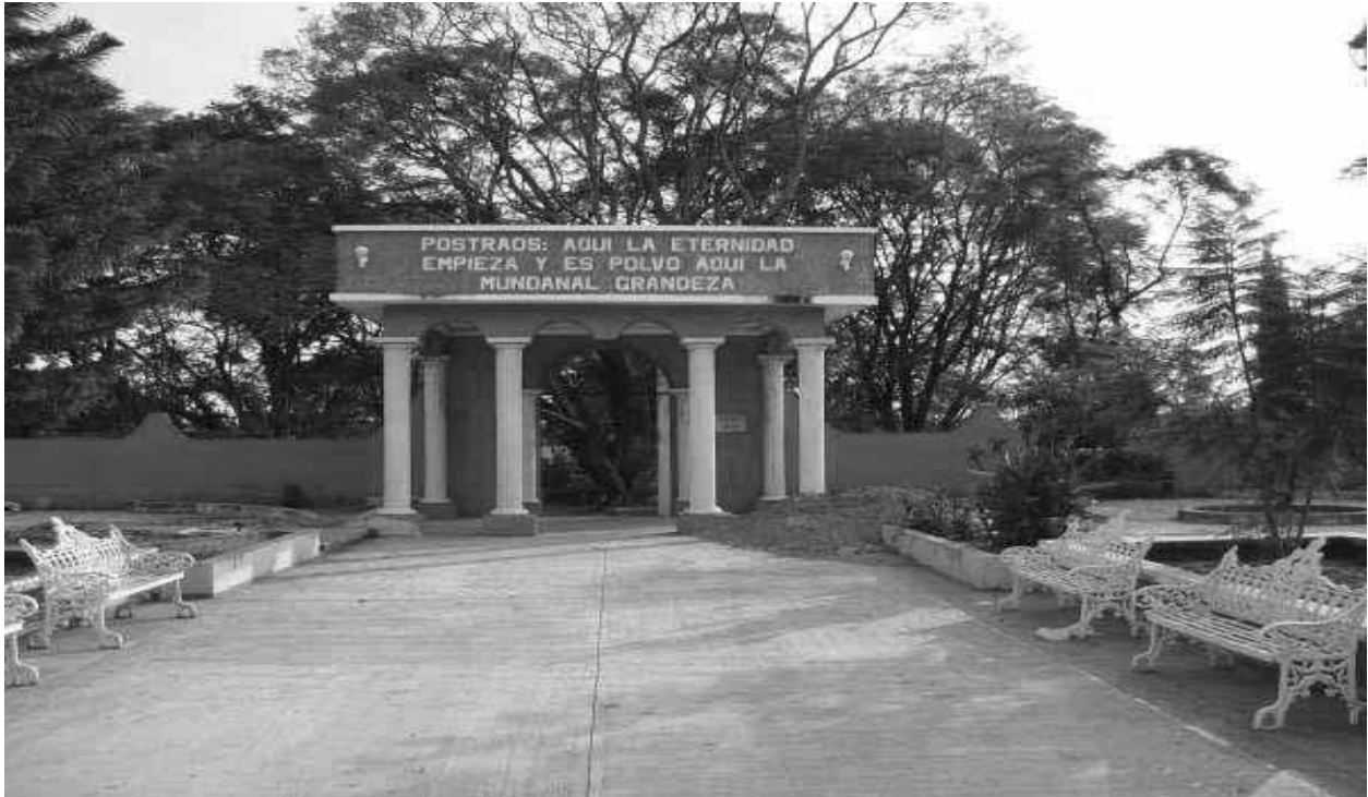
FACHADA PRINCIPAL DEL PANTEON MUNICIPAL.
