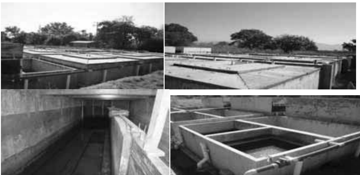
Figura.13 planta de tratamiento de aguas residuales de San Raymundo Jalpan
