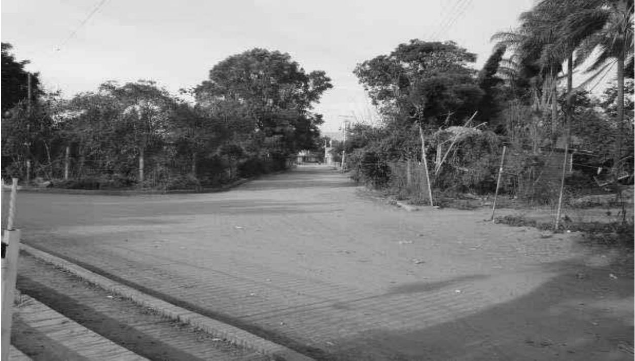
CALLE PRINCIPAL UNION DE CALLE PAVIMENTADA Y DE TERRACERIA QUE POR EL ARRASTRE EN EPOCAS DE LLUVIAS SE ENCHARCA.
