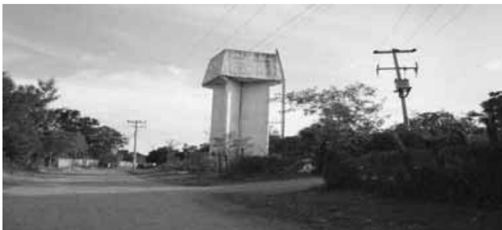
Figura.12 pozo que surte agua potable a la comunidad.
