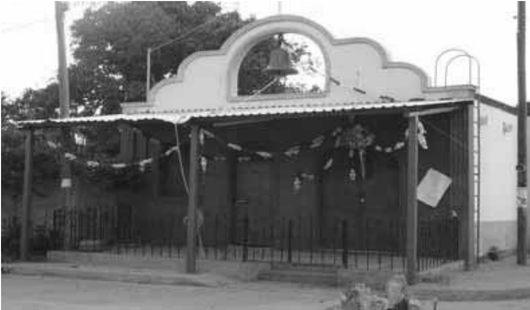
Fig. 15.-Capilla de Santiago Apóstol.
