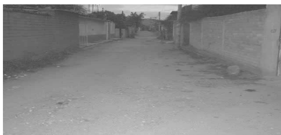
El 90 % de las calles no están pavimentadas
