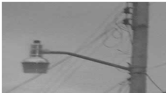
Condición actual del alumbrado publico
