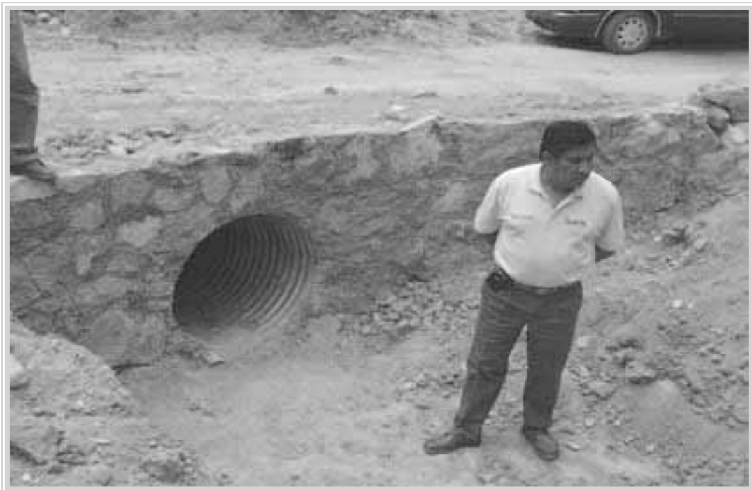
Imagen: Obras de caminos en la comunidad de Santa María Cuquila, Heroica Ciudad de Tlaxiaco..
