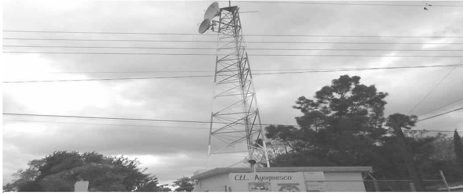
Foto 5. Antena telefónica de teléfono fijo o de casa
