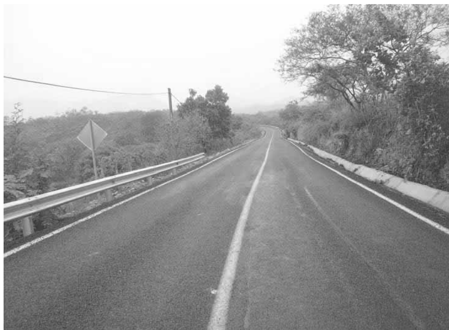
Obra reciente del entronque de la carretera federal margen izquierdo Con dirección a la Cabecera Municipal Santa Maria, Ipalapa
