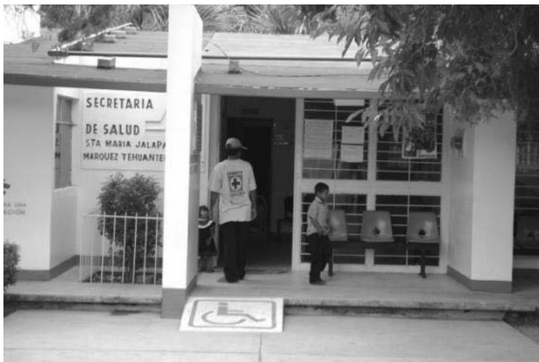
Fig. 29. Centro de Salud del Municipio de Jalapa del Marqués
