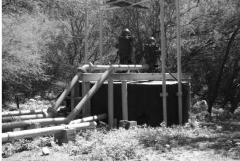
Fig. 30. Pozo municipal de agua potable
