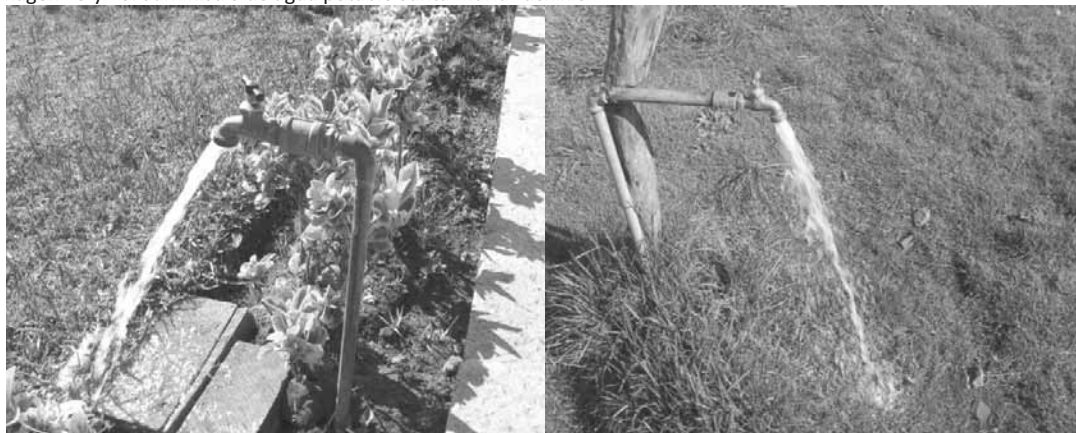
Imagen 15 y 16. Suministro de agua potable Santa María Lachixio
