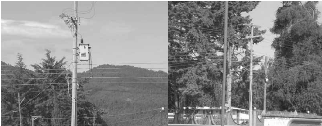
Imagen 13 y 14. Sistema de electrificación Santa María Lachixio
