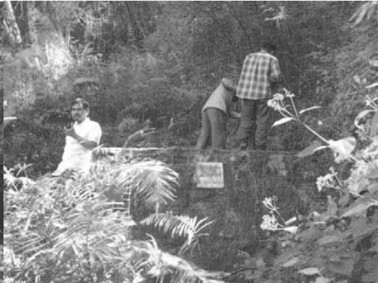
Limpieza y saneamiento de depósito de agua
