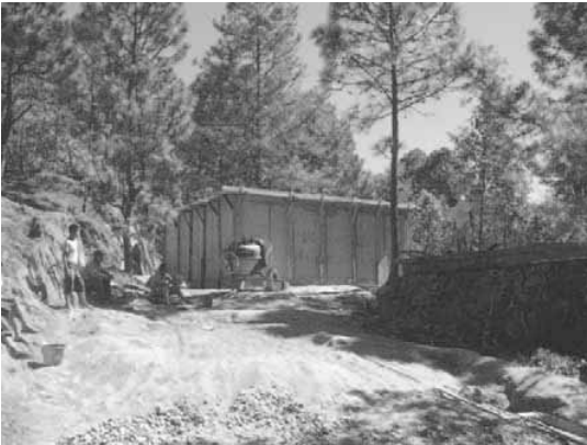
Construcción de depósito de agua
