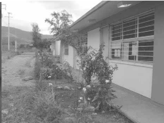
Instalaciones de IEBO
