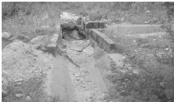
Canaletas de riego en pésimas condiciones
