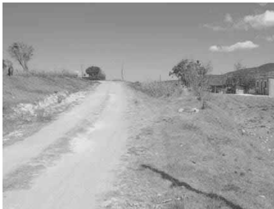
Foto 10.- Terracería que conduce a Santa Maria Nativitas
