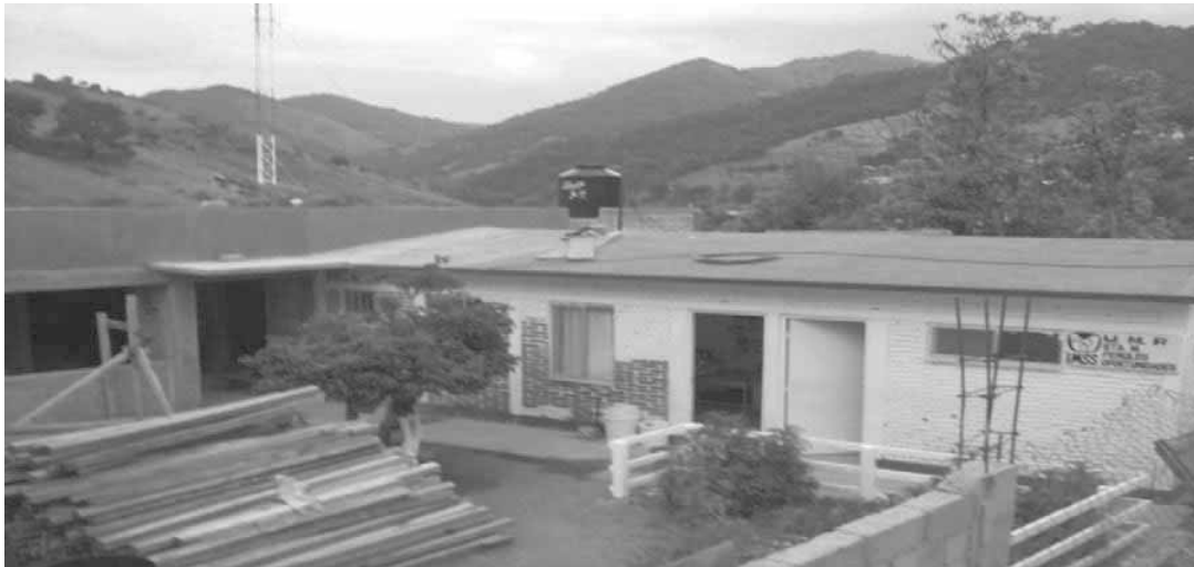
Centro de salud en ampliación de la cabecera municipal de Santa María Peñoles.
