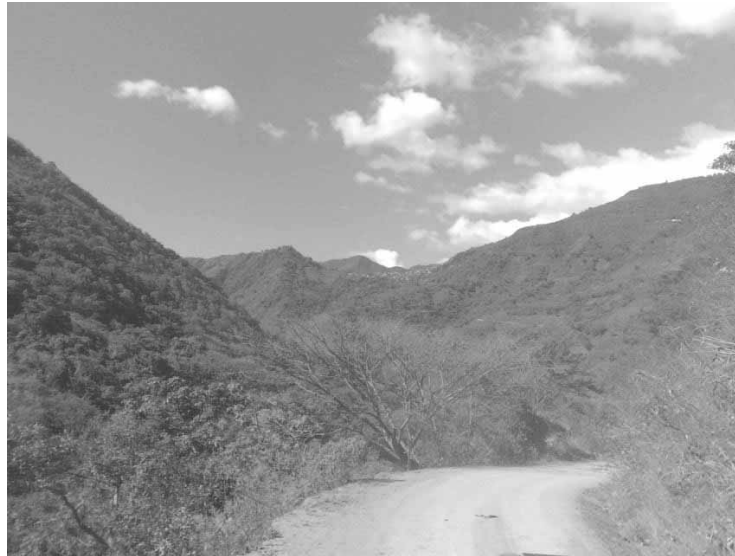
Camino de Terracería. Principal Acceso a Santa María Temaxcalapa
