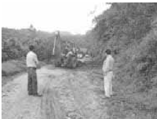
Mantenimiento de vías de acceso (limpia de derrumbes)
