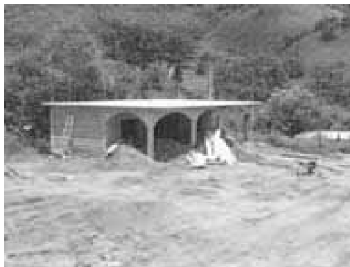
Construcción de la agencia San José Pie del Cerro
