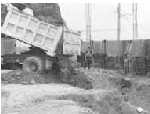
Relleno de fosas y canales
