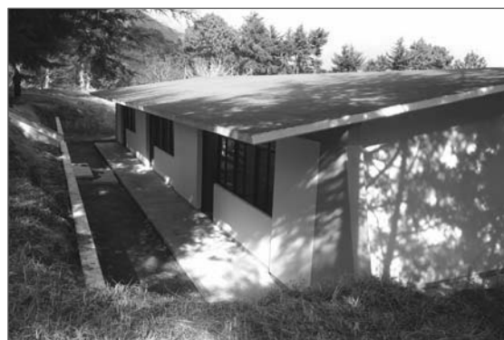
Instalaciones del TEBAO,
