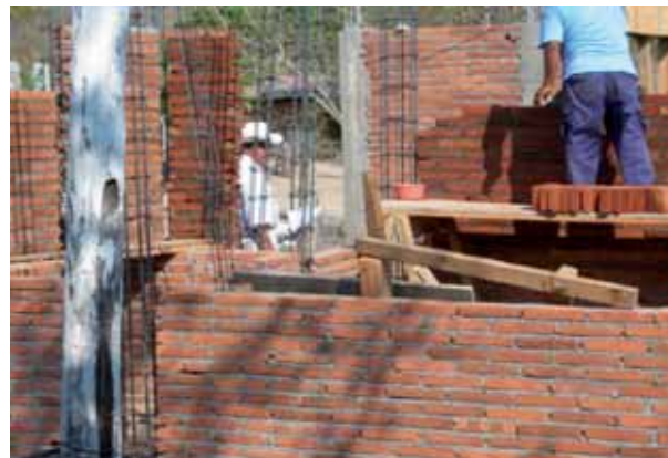
Fig.3 Construcción de la casa de salud de la frutilla ton.
