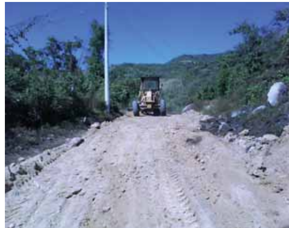
Fig. 13 Rehabilitación de caminos en las comunidades.
