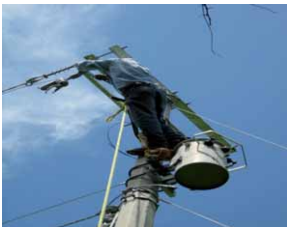
Fig.5 Ampliación de red eléctrica en paso lagarto ton.
