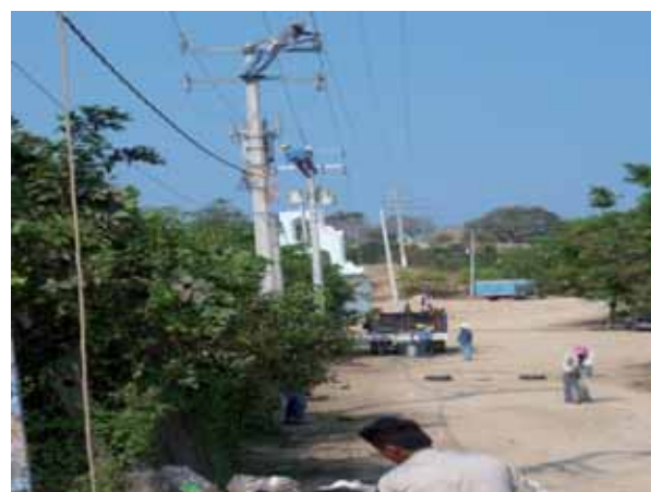
Fig.6 Ampliación de red eléctrica en san Antonio ton.
