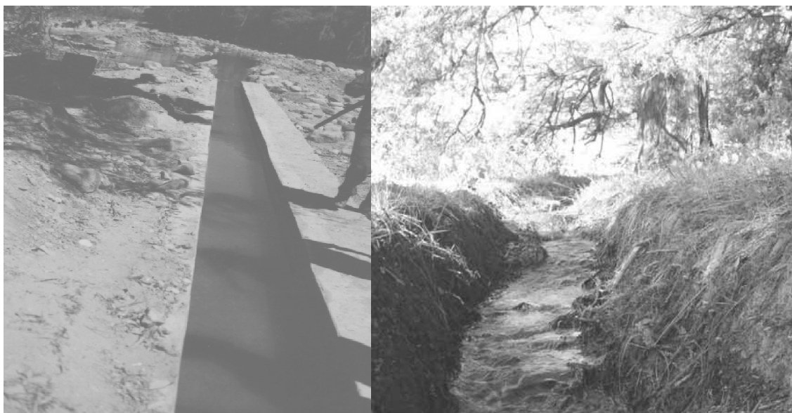
Imagen 10. Canal de riego que requiere de rehabilitación para optimizar la conducción del agua.
