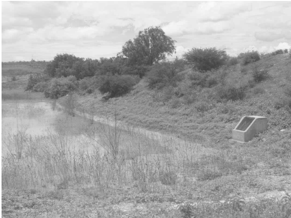
Foto tomada en recorrido
