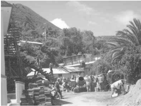
Anexo 17. Albañiles trabajando
