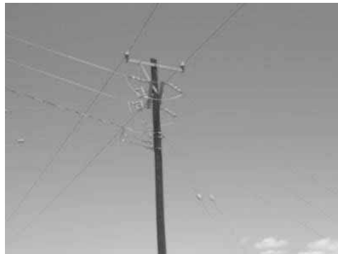
Anexo 8. Ampliación y mejora de la red de distribución de energía eléctrica
